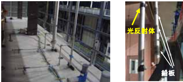
写真-3 加震前のステンレス配管取り付け状況 (2階) 各階の取出し管 25 には SAS322 (ステンレス協会規格) 継手を用いた。また、各階の支持は、各階床上のアンクル材とリボルトで固定した。
