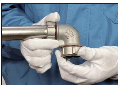
8. Posizionare la rondella conica nella parte in cui l'estremità del dado di serraggio entra in contatto con il raccordo, e serrare il dado fino a quando la superficie colorata non è più visibile.
