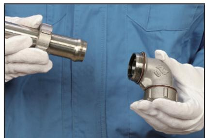
6. Inserte la tubería ampliada en el accesorio y apriete la tuerca
